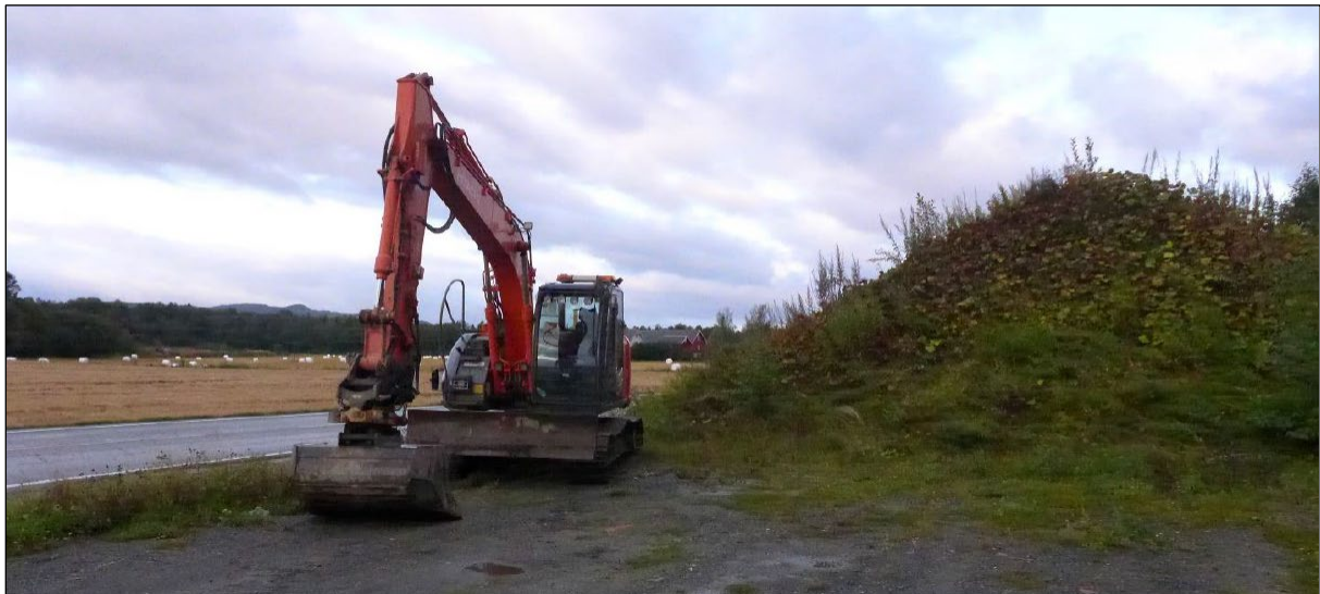
Figur 53. Jordvoll med forurensede masser på nordside av E14, ved Ystineset.
