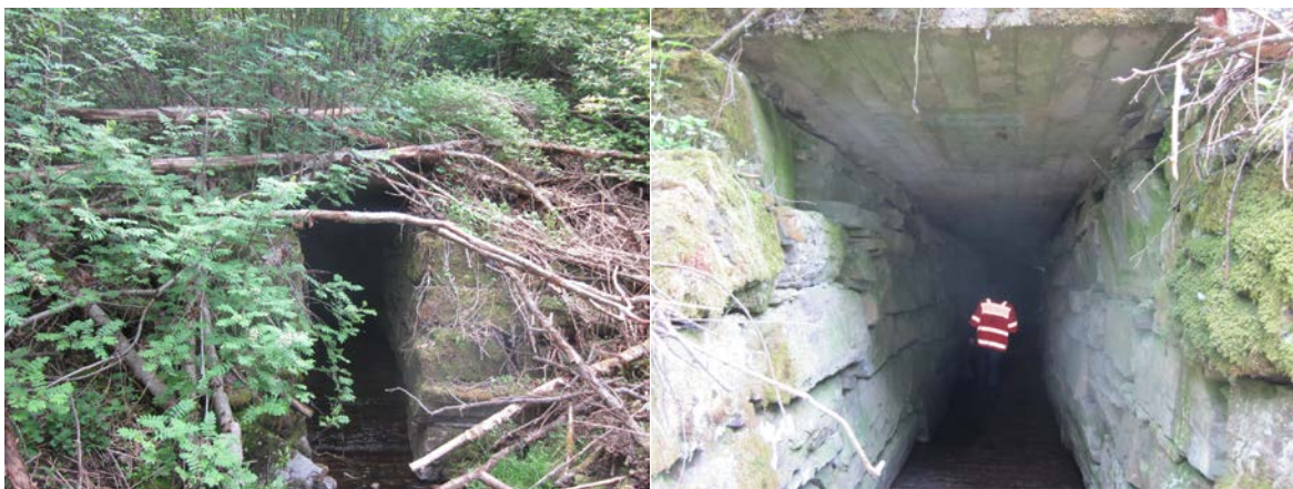
Eksisterende kulvert Gluggbekken
