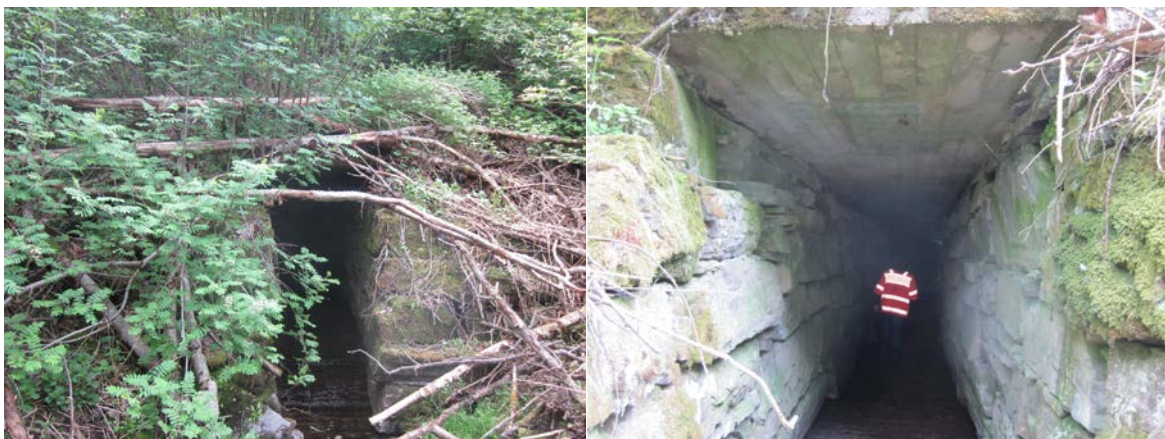
Eksisterende kulvert Gluggbekken
