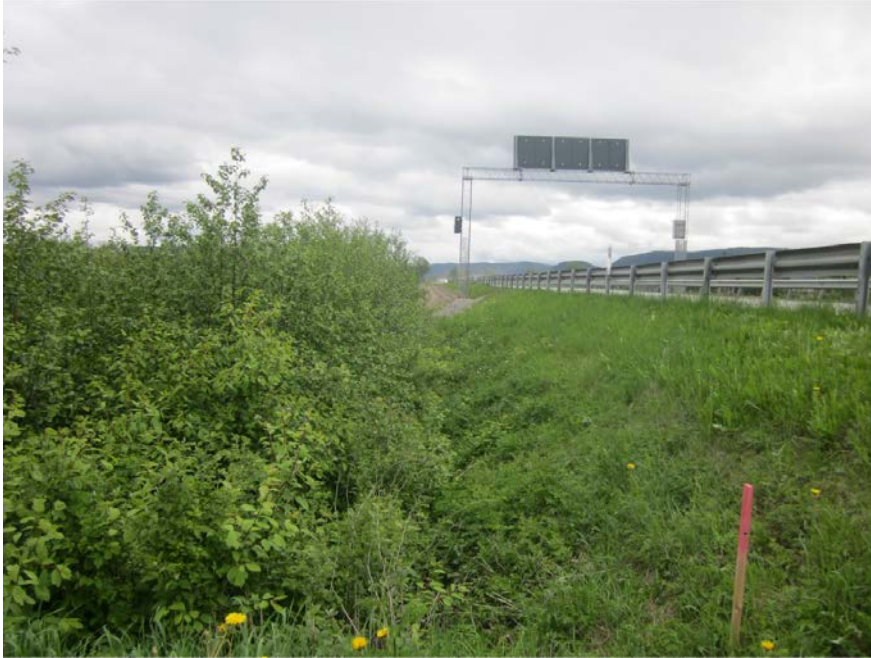
Bilde ca i senterlinje ny bru
