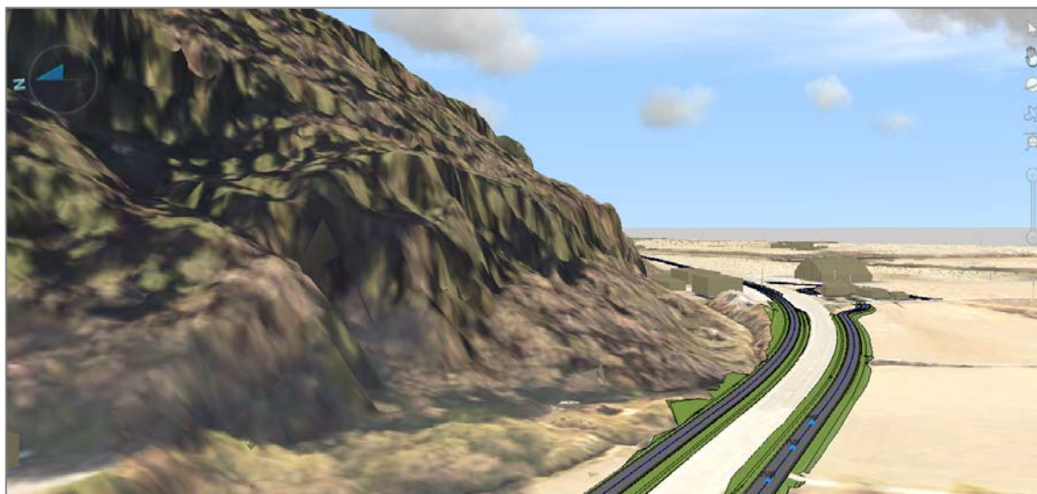
Figur 6: Området som er innenfor aktsomhetsområde for skred, omtrent 1530 til 1660, sett mot øst. Karakteristisk terrengform som tyder på urmasser under bergskrent.
