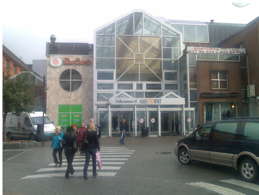
Figur: Glass-gården i gågata i Bodø som framstår som en bygning.
