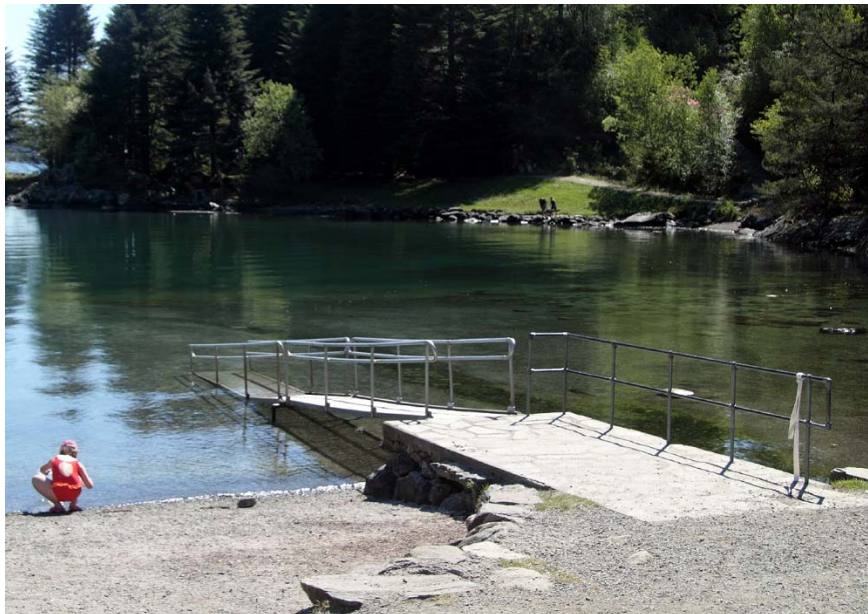
Fra badestrand i Kristiansand, med universell utforming. Baderampen er i strekkmetall, med rekkverk på begge sider, med håndlist i to høyder. Rampen er montert på støpt brygge.
