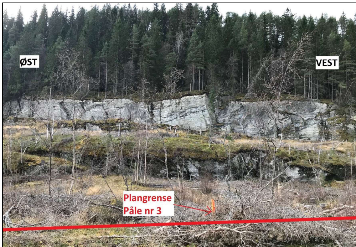
Figur 14 Foto av klatrevegg med pangrense påle nr. 3 i forgrunnen. Foto 16.11.18
