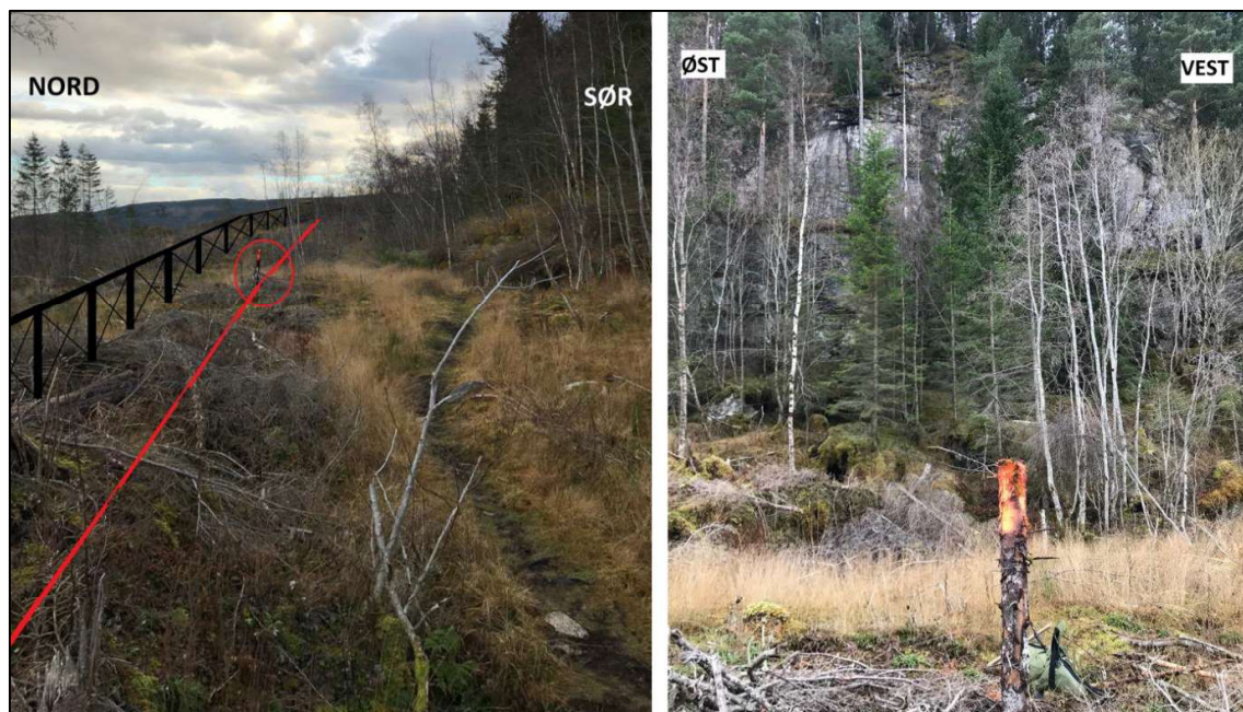
Figur 13 Plassering av sikringsgjerde ved påle nr. 06. Foto 16.11.18
