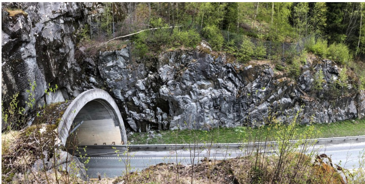
Figur 10. Eksisterende østre påhugg for Stavsjøfjelltunnelen. Berget er lite til moderat oppsprukket. Forskjæringen og påhuggflaten er sikret med til sammen ca. 30 stk. bergsikringsbolter.
