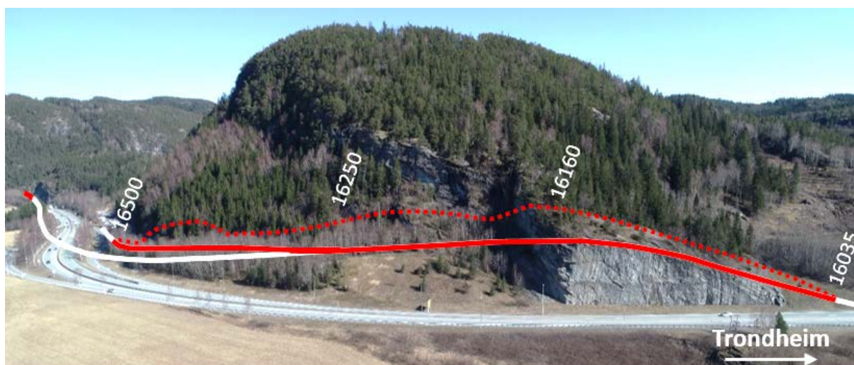
Figur 14. Dronefoto for oversikt over Hommelvikskjæringa. Heltrukne linjer angir omtrentlig senterlinje for prosjektert E6. Rød farge angir senterlinjen i områder der det er planlagt bergskjæring, og rød stiplet linje angir omtrentlig prosjektert skjæringstopp.
