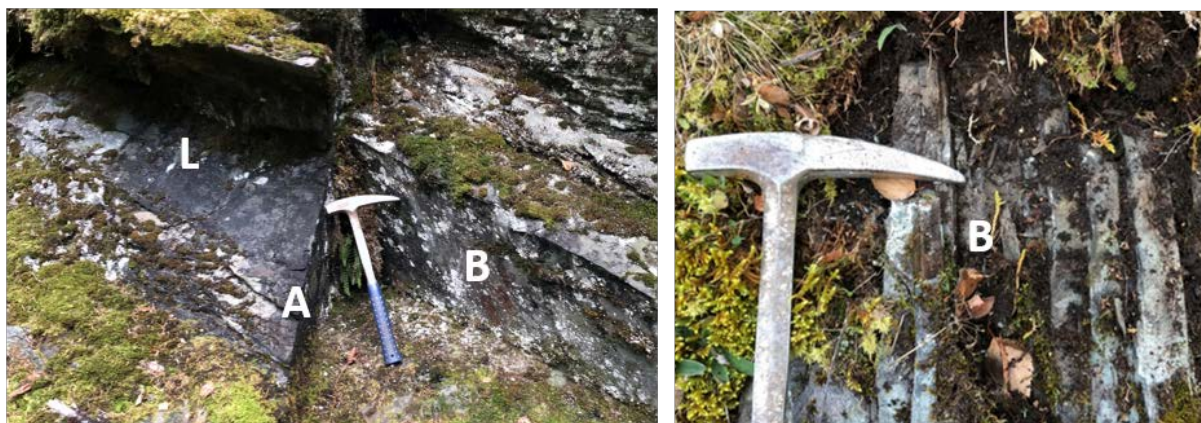
Figur 18. Øverst: Eksisterende bergskjæring langs E6 ved Hommelvik. Største høyde er ca. 28 m over bunn grøft. Berget er i store områder lite oppsprukket til massivt. Hvit stiplet linje viser gjennomsettende sprekk langs L. Røde linjer viser sprekksett A. Nede til venstre: Sprekkesett L, A og B, observert et stykke øst for eksisterende bergskjæring. Nede til høyre: Tett oppsprekking langs sprekksett C observert rett innenfor topp av eksisterende bergskjæring.
