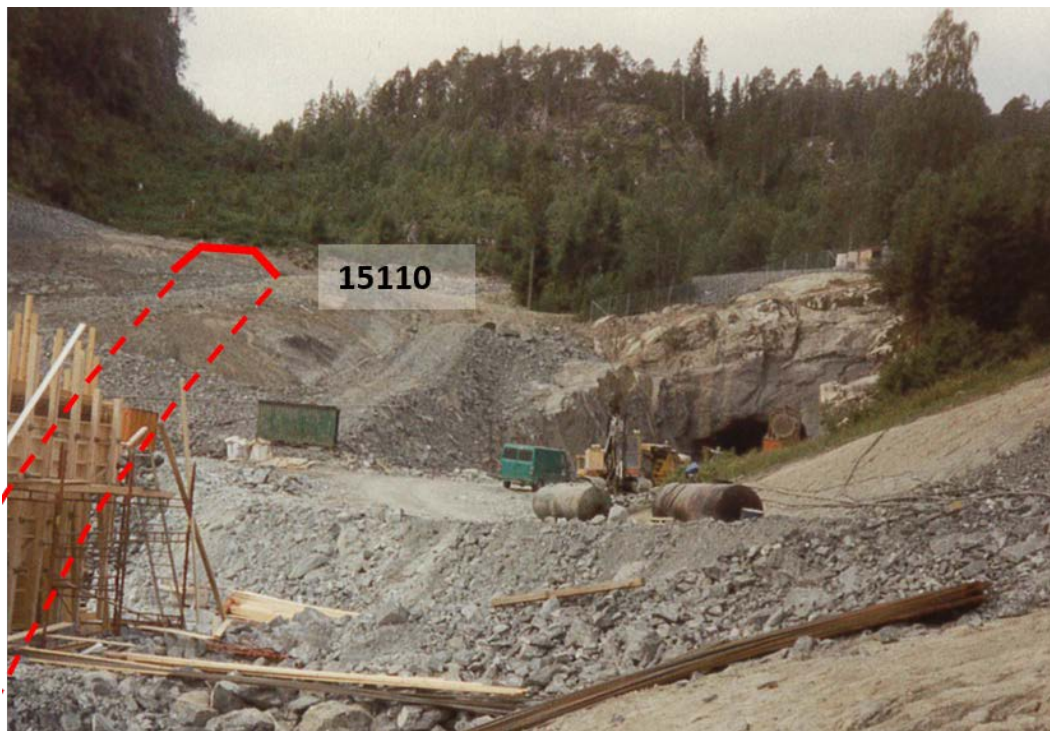
Figur 8. Foto tatt av Svein Hove i Statens vegvesen under bygging av Stavsjøfjelltunnelen på slutten av 1980-tallet. Påhugget til eksisterende tunnel er synlig til høyre i bildet. Røde linjer indikerer fotavtrykk for prosjektert E6 og påhugg for nytt tunnelløp.
