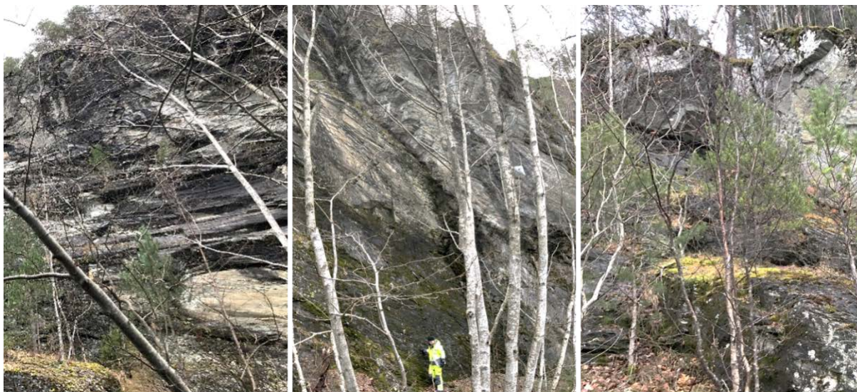
Figur 15. Bildene viser bergskrenten rett ovenfor prosjektert skjæringstopp i området mellom profilnummer ca. 16180 og 16220.
