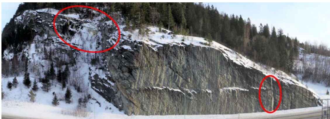
Figur 23. Isdannelse observert vinteren 2019. Røde ellipser markerer observert is.
