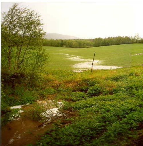
Underdimensjonert rør gir overvann
