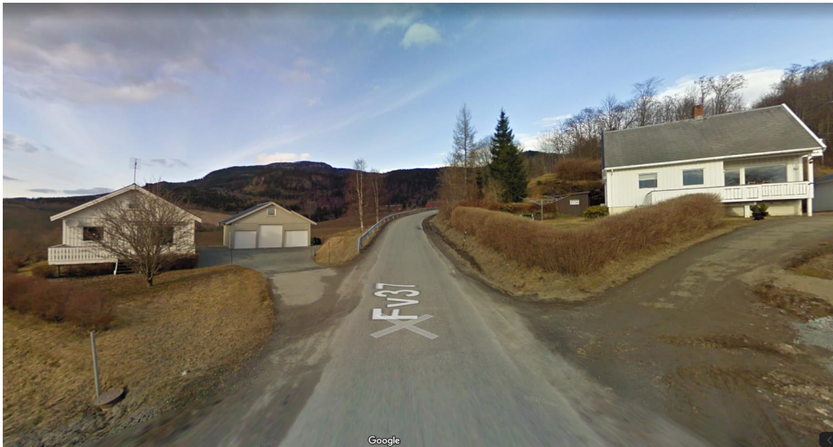
Figur 6-5 Sikt ved avkjørsler til Holvegen 51 (til venstre) og Holvegen 50 (til høyre)
