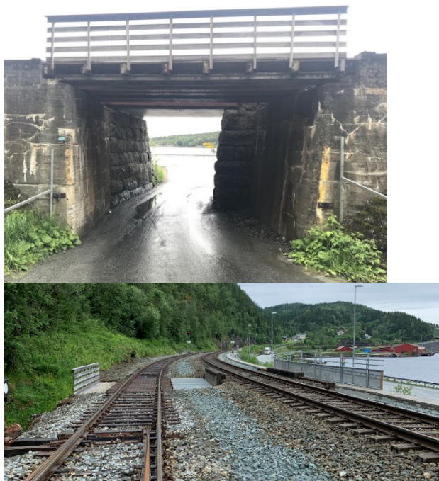
Figur 2-1: Bilder av eksisterende situasjon
