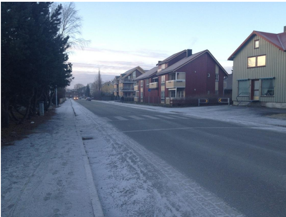
Ole Vigs gate med sykkelfelt og opphøyde gangfelt i 30 km/t sone
