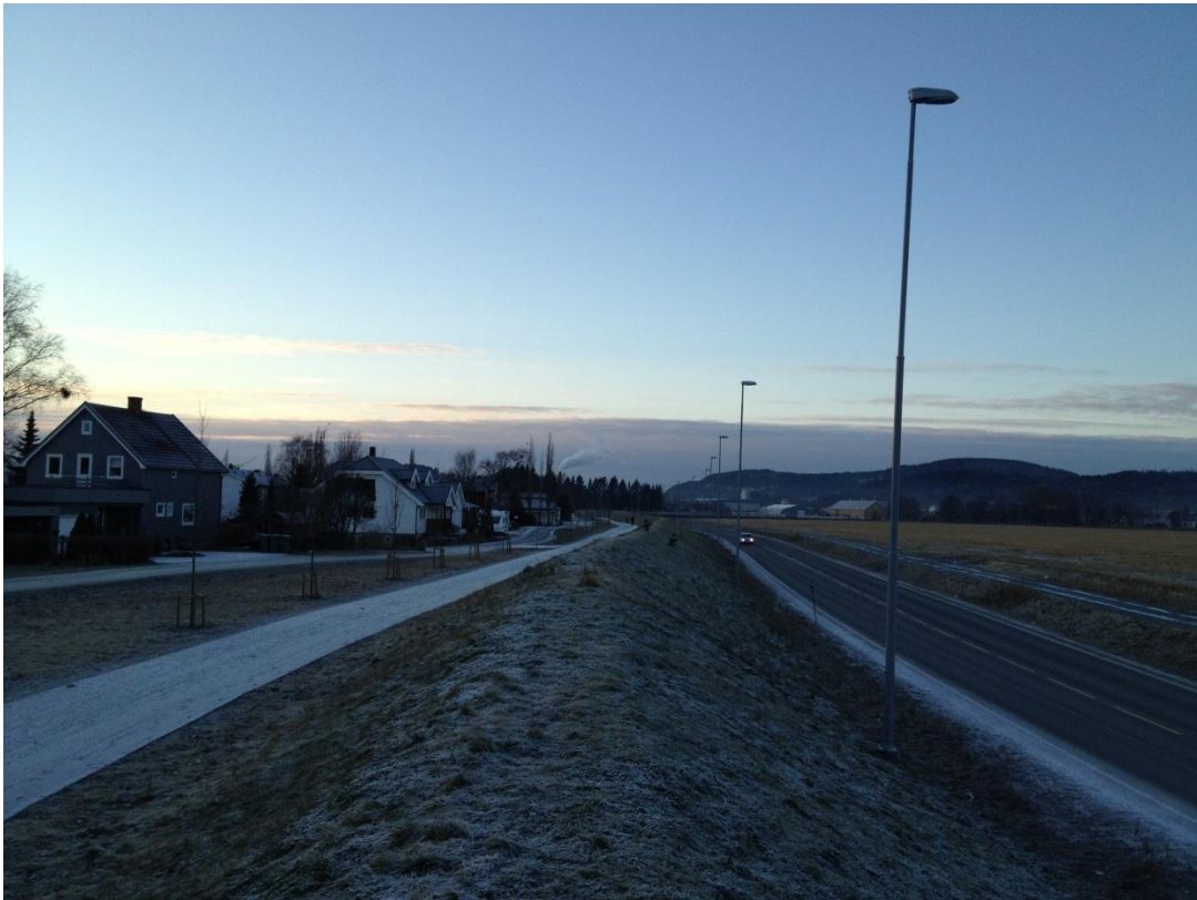
Gang- og sykkelveg parallelt med ny Ringveg nord parsell A. Her nord for Gammelverksgata.
