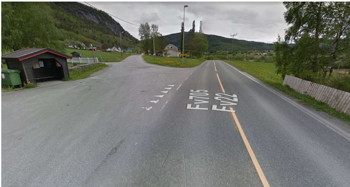
Figur 4-3 Bildet viser krysset mellom fv.705 og fv.6784, sett fra vest (Google Maps).
