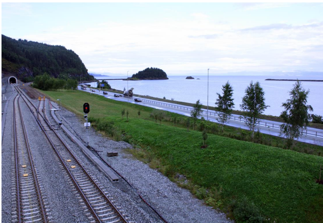
Figur 3-4. Bildet viser plasseringen av eksisterende jernbanelinjer og jernbanetunnel sett i forhold til dagens E6. Muruvik sidespor går over tunnelportalen til E6. Foto: Trondheim Havn, 23.08.11, hentet fra https://no.wikipedia.org/wiki/Gev%C3%A5sen_tunnel .
