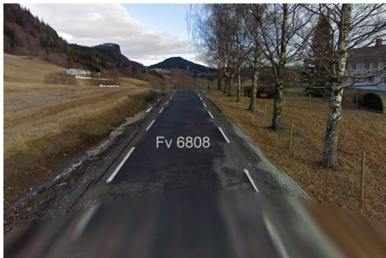
Figur 32 Eksisterende situasjon. Dårlig sikt i kurve ved punkt 7 i figur 25. Kilde Google street view
