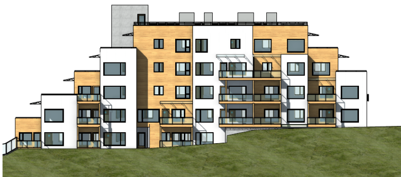
Fasade mot sørøst
