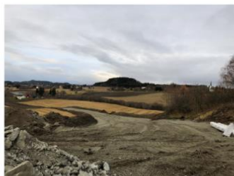
Figur 1: Ploglaget er tatt av til siden, og "steinmel" er lagt på undergrunnsjorda (B-sjiktet).
