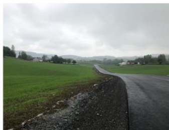
Figur 2: Første vekstsesong. Asfaltert anleggsveg med duk som er helt ut til siden.
