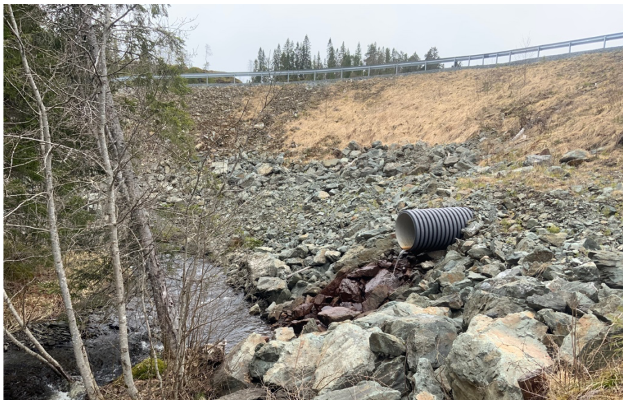
Figur 8. Utløpet til bekken går gjennom rør, under fv.42, og renner ut i Langsteinelva.
