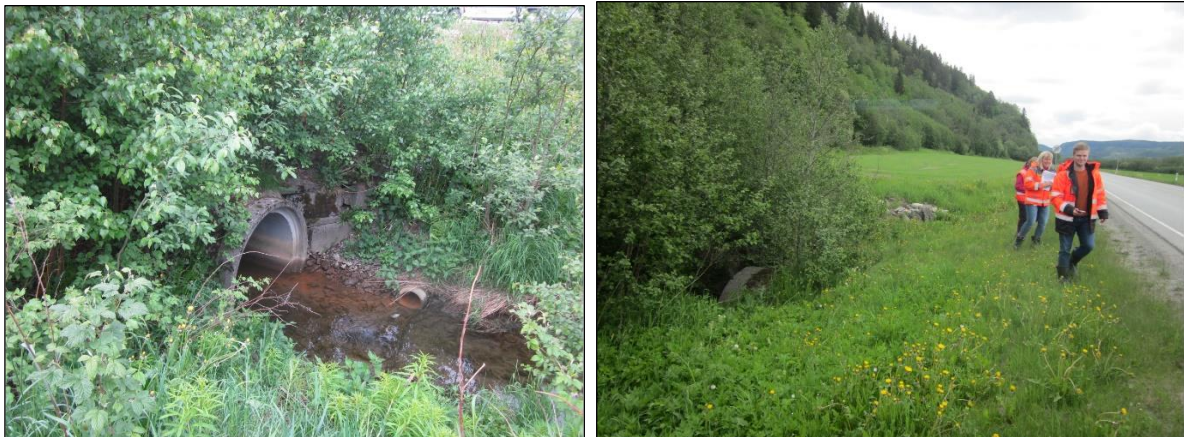
Figur 37. Til venstre vises stikkrenne ved Ligaardskrysset. Til høyre er stikkrenne ved Ystinesberget.
