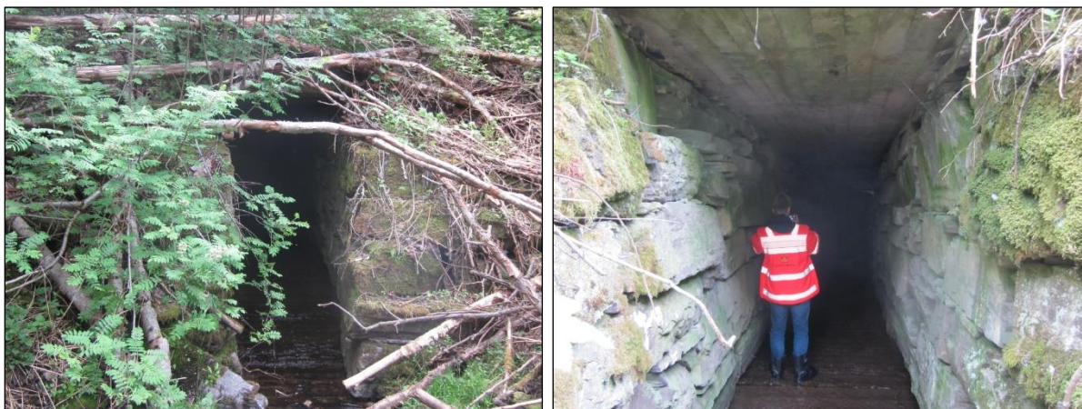
Figur 11. Gluggbekken kulvert. Åpning oppstrøms til venstre og bilde til høyre viser vegger og tak.
