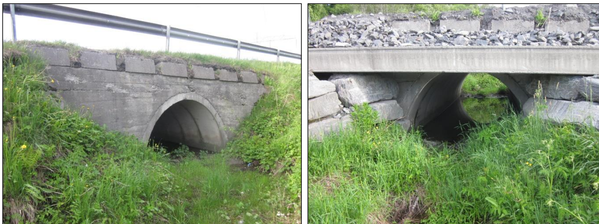
Figur 12. Husdyrkulvert ved Håvereina fra nordside til venstre, og på sørside til høyre. Undergangen er forlenget på sørsiden.
