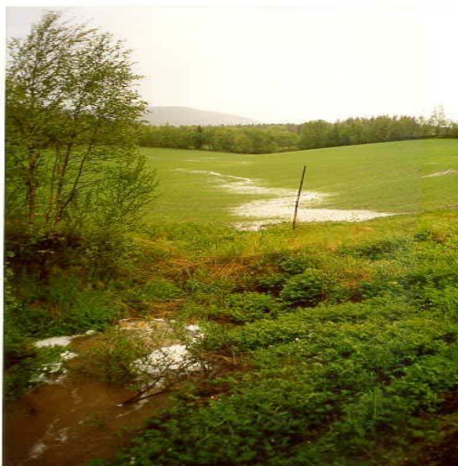
Underdimensjonert rør gir overvann
