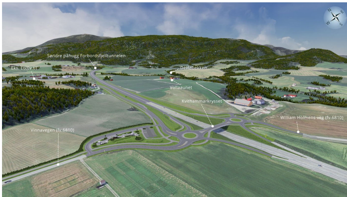
Figur 2: Veglinja fra Kvithammarkrysset mot nordøst.
