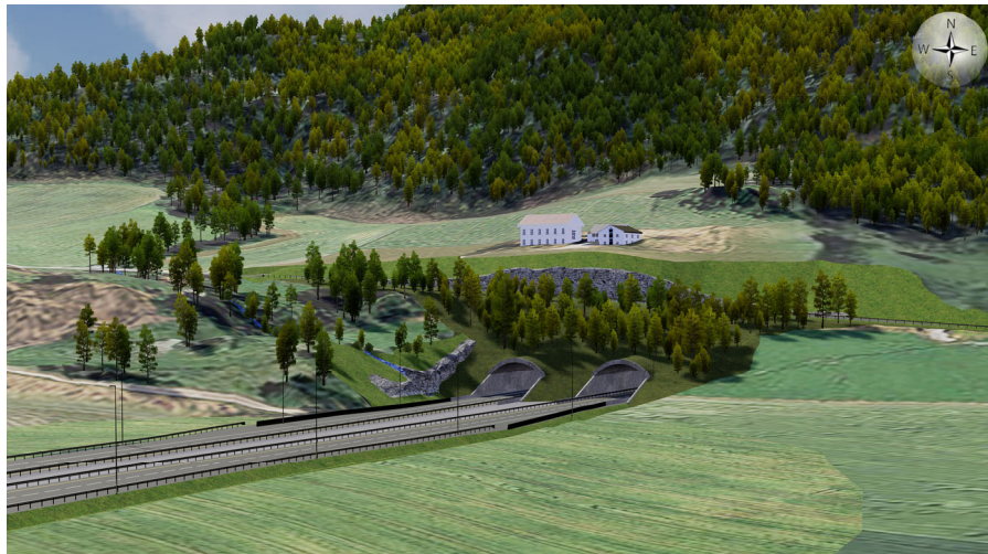
Figur 4-42. Søndre påhugg Forbordsfjelltunnelen, sett mot nord.
