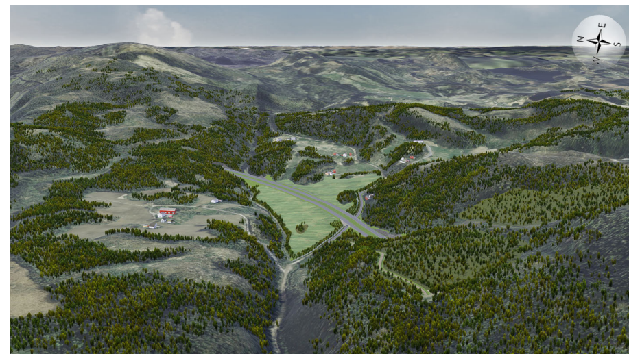
Figur 4-18. Langsteindalen sett mot øst. Terrenget løftes opp til E6 over et større område på begge sider av vegen.
