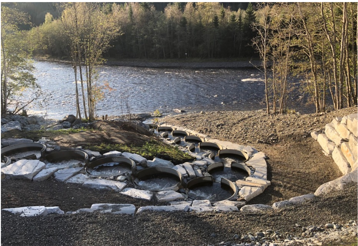
Figur 50 Under oppgraderinger av veien mot Forradal i Flora, ble kulvert og oppgangshinder i Florbekken under E14 utbedret med ny fisketrapp. Bildet viser nedre del av fisketrappen mot Stjørdalselva. Foto: Ida Eggen, NVE.
