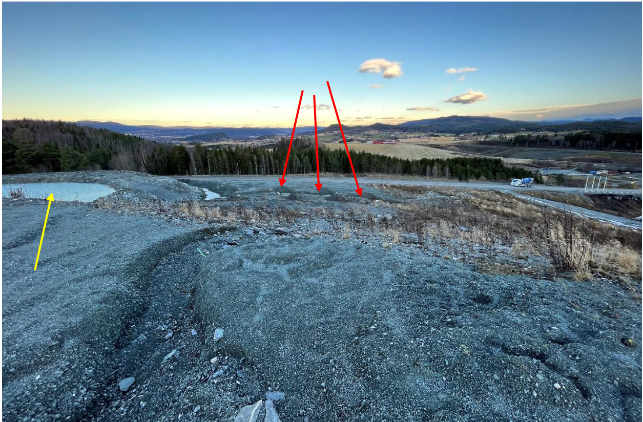
Figur 4-2 Foto av damanlegg for vaskevann fra betongbiler tilhørende Betong Øst. Dam (gul pil) og "sedimentasjonsdammer" for utfelling av kalk i nedkant dam (røde piler).
