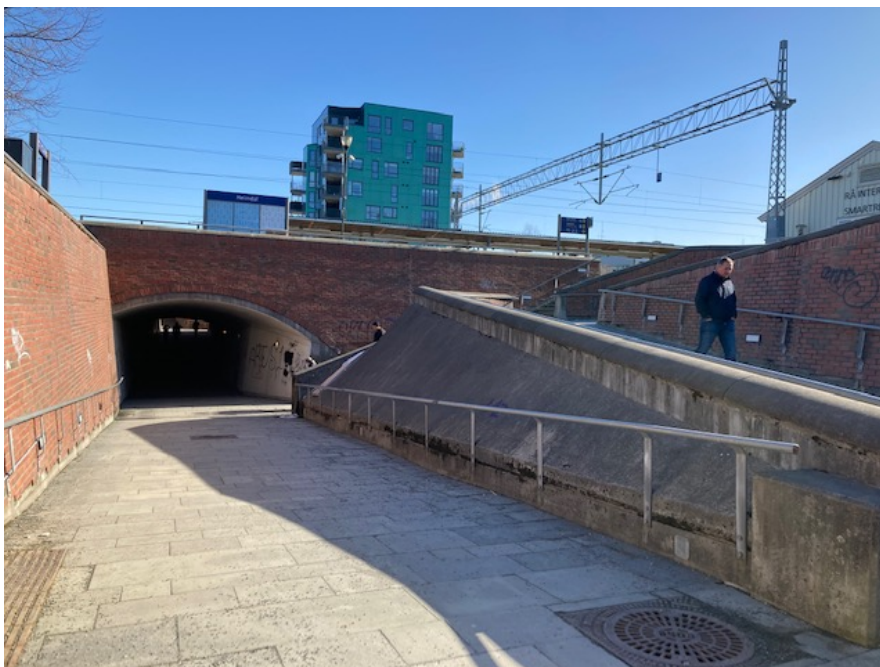
Eksempel 2. Heimdal stasjon med ramper, trapp og undergang. Bredde er 5,5 m i åpning og 4,3 m inne i kulvert. Det er ikke skille mellom gående og syklende på Heimdal.
