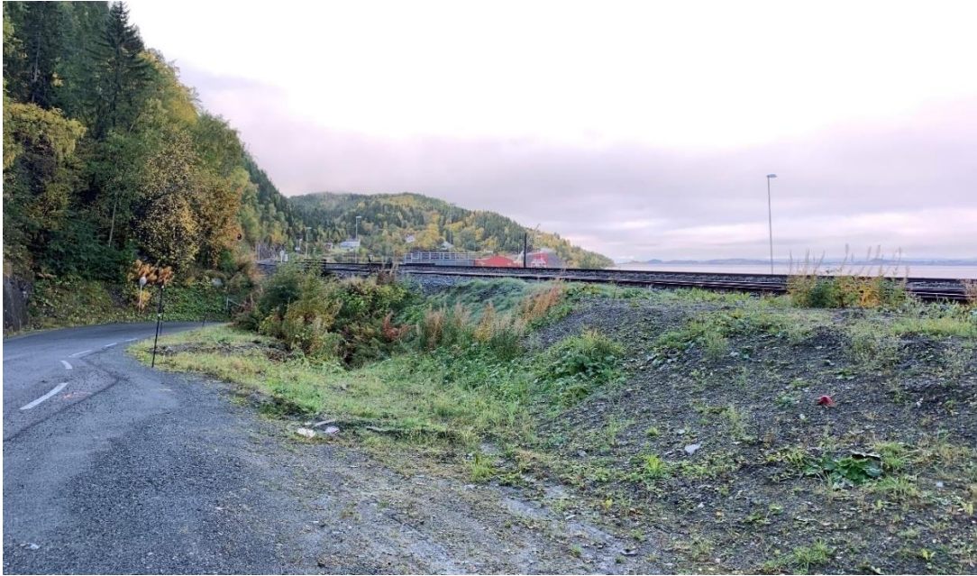
Figur 17: Bilde fra avkjøring/grusplass til Salmar sitt anlegg fra fv. 6816 Langsteinvegen, samt eiendom tilhørende Bane NOR. Nordlandsbanen med sideareal (Selberg Arkitekter 02.10.2019).
