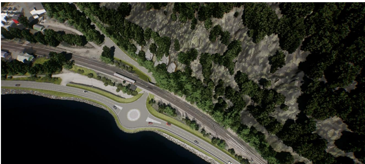
Figur 30: Midlertidig situasjon med rundkjøring i fasen med anleggsarbeid tilknyttet ny E6 Kvithammar-Åsen.
