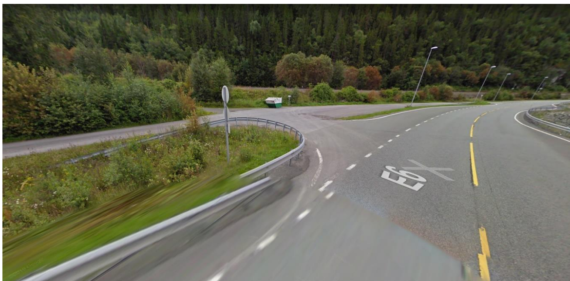
Figur 14: Dagens E6 og avkjøring til atkomstveg for bolighus/Stjørdal Antikk og Brukt, den nedlagte Langstein togstasjon, samt tilkomst til trafikkromme fra nord (Kilde: Google maps streetview).
