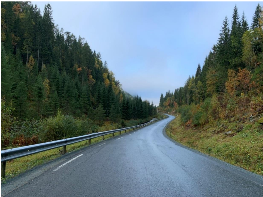
Figur 18: Fv. 6816 Langsteinvegen sett fra øst mot vest i Langsteindalen (Selberg Arkitekter 02.10.2019).
