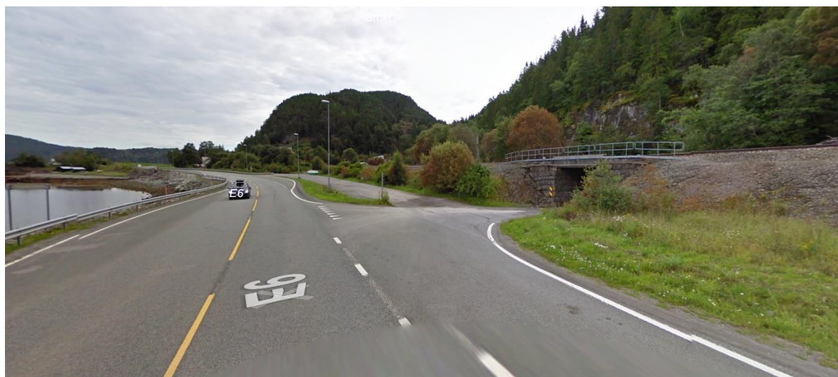
Figur 13: Dagens E6 og avkjøring til fv. 6816 Langsteinvegen som går under Nordlandsbanen (Kilde: Google maps streetview).
