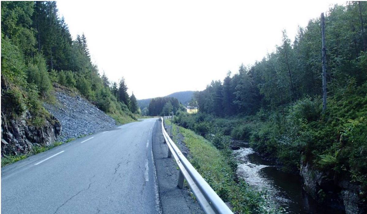
Figur 5. Bilde tatt ca. 2,3 km opp i Langsteinvegen fra E6. Det kan være aktuelt å utvide med møteplass og skjæring på nordsiden (venstre side på bildet) av veg i dette området. Foto: Sweco.
