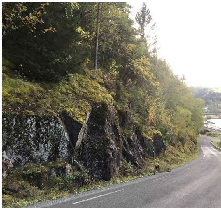
Figur 4. Bilde tatt ca. 300 m opp i Langsteinvegen fra E6. Det kan være aktuelt å utvide med møteplass og skjæring på sørsiden (venstre side på bildet) av veg i dette området. Foto: Sweco.
