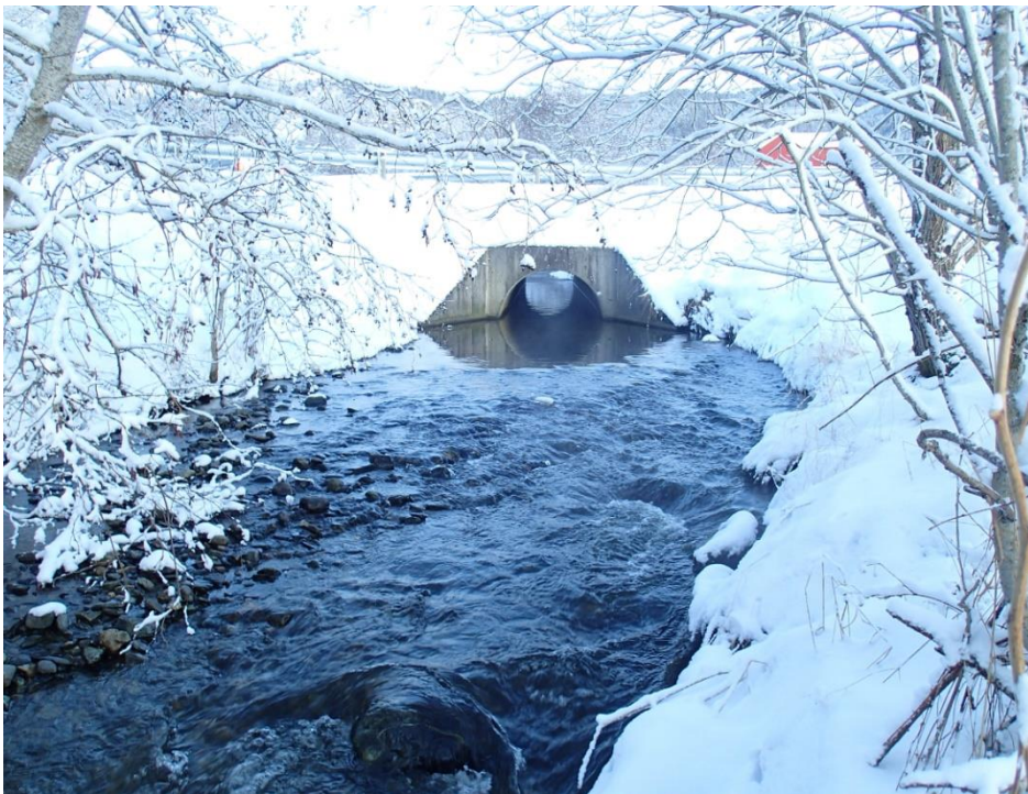
Figur 4-4 Holelva med kulvert under Holvegen, Foto: Sweco
