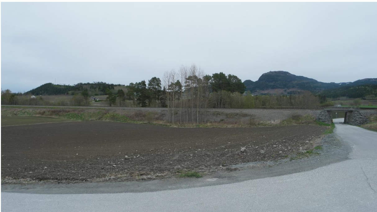
Figur 4-3: Like utenfor planområdet i sør er en undergang der Rykkjasvegen går under. I denne delen av planområdet vokser det en del vegetasjon på østsiden av sporet som her går på fylling.
