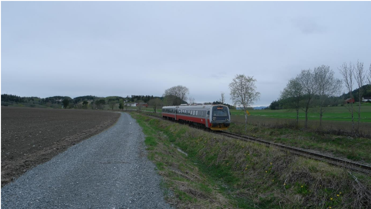
Figur 4-2: Langs østsiden av jernbanesporet går det en grusveg. Mellom denne og jernbanen løper en grøft som samler opp vann. Gården Alstadhaugen er synlig bak i bildet. Nordgående tog er på vei.
