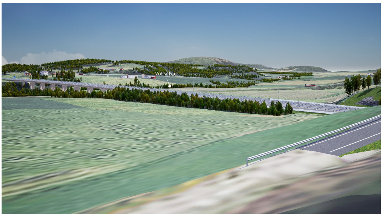
Figur 31: Bakkeperspektiv fra boligbebyggelse ved Hollan, i Holvegen 205, øst for tunnelportalen. Ser mot sørvest og kryssing av Vollselva. Vegens sideterreng er fylt opp og slaket ut med en helning på 1:10 ned mot eksisterende dyrka mark på vestsiden. På måten vil vegen oppleves som en mer integrert del av det bølgende jordbrukslandskapet i området. På østsiden beholdes vegens bratte sideterreng, og Raudhåmmårbekken går i bunn av vegskråningen. Bekken med kantvegetasjon beholdes som en linje i landskapet. Vegen ligger godt i terrenget og oppleves ikke som en visuell barriere eller en «demning» i terrenget.
