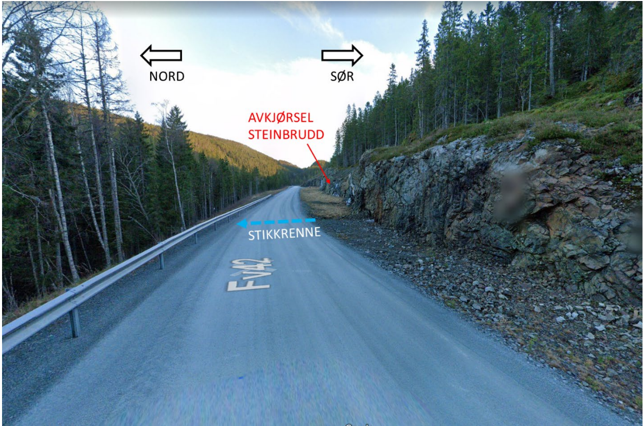
Figur 1 Langsteinveien sett fra vest mot øst, inntegnet eksisterende stikkrenne og planlagt avkjørsel
