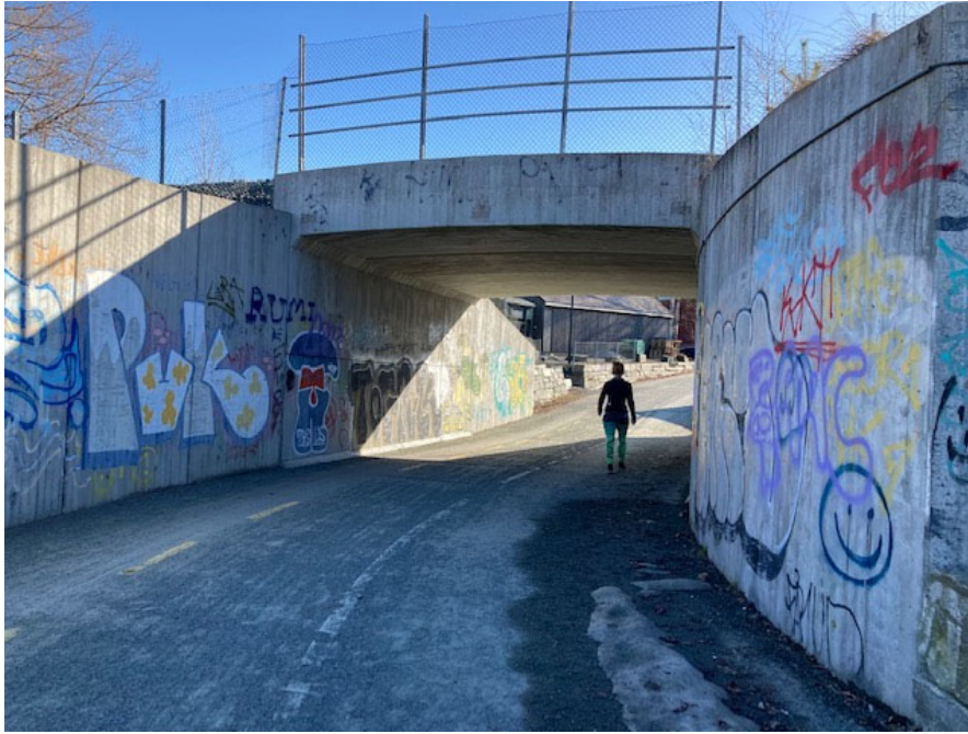
Eksempel 3. Dalen undergang i Trondheim, sykkelveg med fortau. Bredde på kulvert er 5,5 m.
