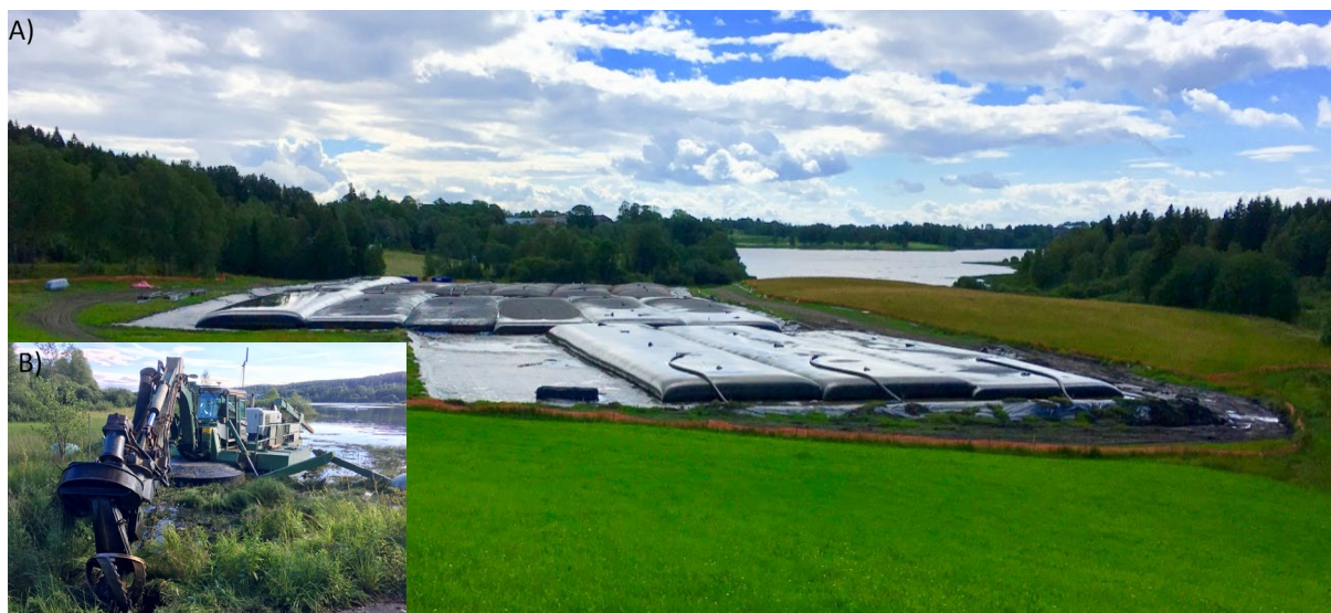
Figur 7 A) Avvanningsområdet med Geotuber på avvanningsområdet og Bogstadvannet i bakgrunnen. De sorte Geotubene ble stablet i 2 - 3 høyder. Vann fra avvanningen drenerte til et membran-dekket basseng og videre til Bogstadvannet. B) Hydraulisk mudring ble utført med en WaterMaster som kuttet, sugde og pumpet sedimentene i rør til Geotubene (Foto: Arnt Olav Håøya).
