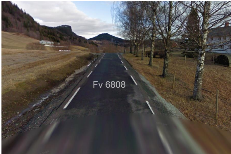
Figur 30 Eksisterende situasjon. Dårlig sikt i kurve ved punkt 7 i figur 25. Kilde Google street view
