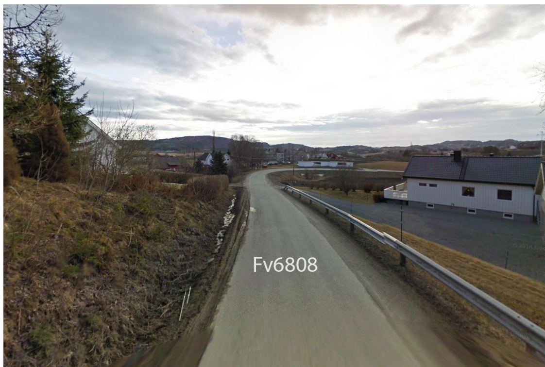
Figur 17 Dagens situasjon langs Holvegen. Utsnitt sett kjørende vestover. Kilde Google street view
