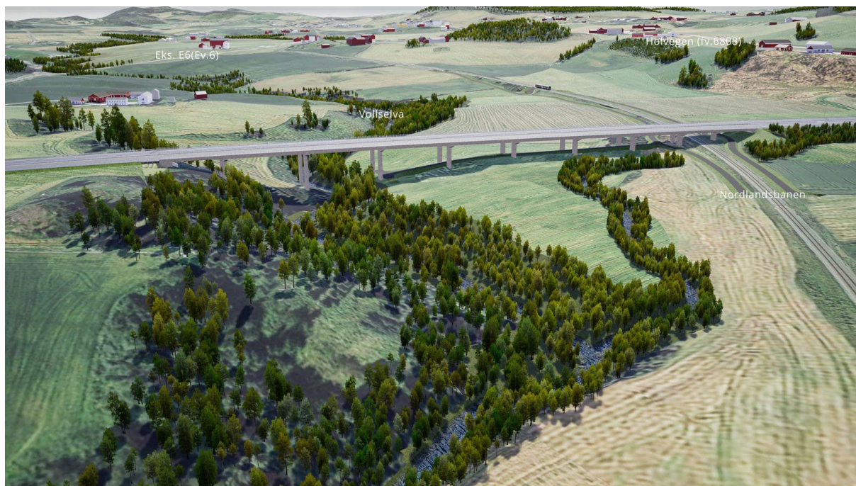
Figur 20 Bru over Vollselva og Nordlandsbanen.
