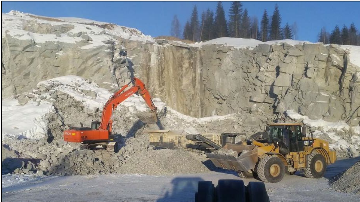
Figur 3 Gravemaskin, mobilt knuseverk og hjullaster som arbeider ved røysa. Foto Tverås Maskin
