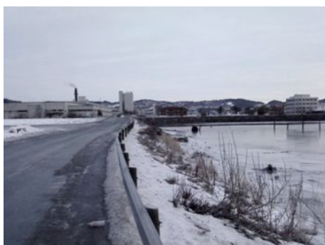
Fv 34 sett vestfra mot brua over Gråelva
