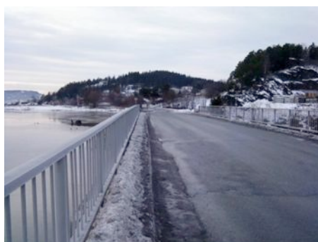
Brua som ikke har gangbane
