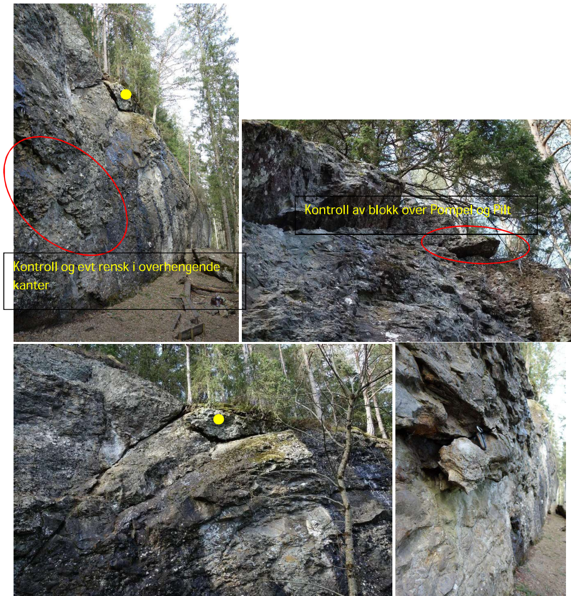
Bilde 5: Lokaltet 2. Bilde ved leirplass ved rutene Pompel og Pilt, omtrent ved GPS 567. Sikring av blokk og generell rensk av bergflate. Felling av trær med røtter i spreken bak avløst blokk.
