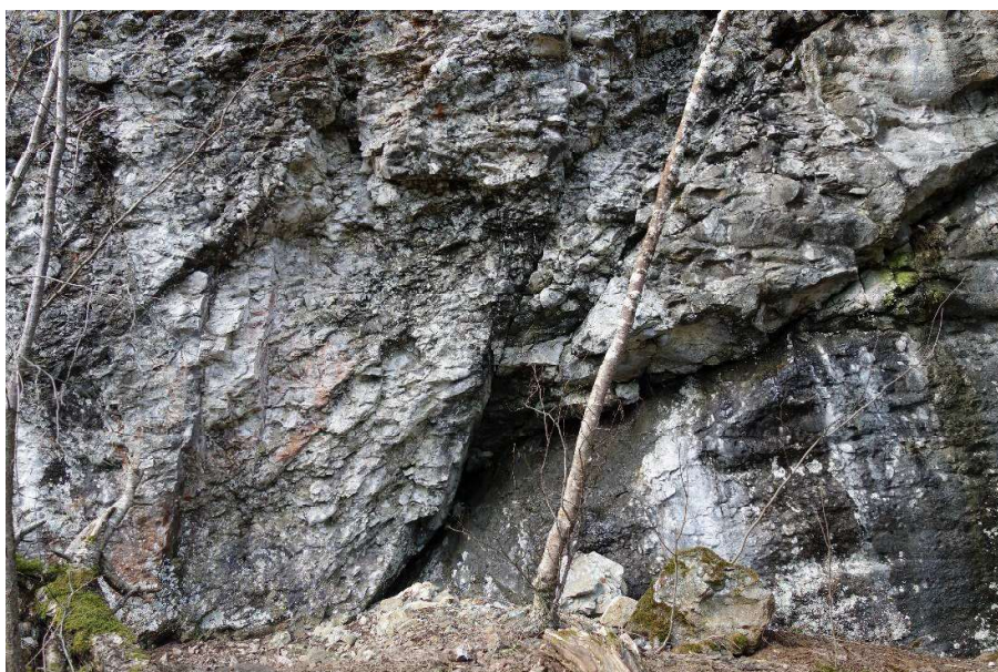
Bilde 3: Bilde av blokkparti. GPS 566. Observasjon.
