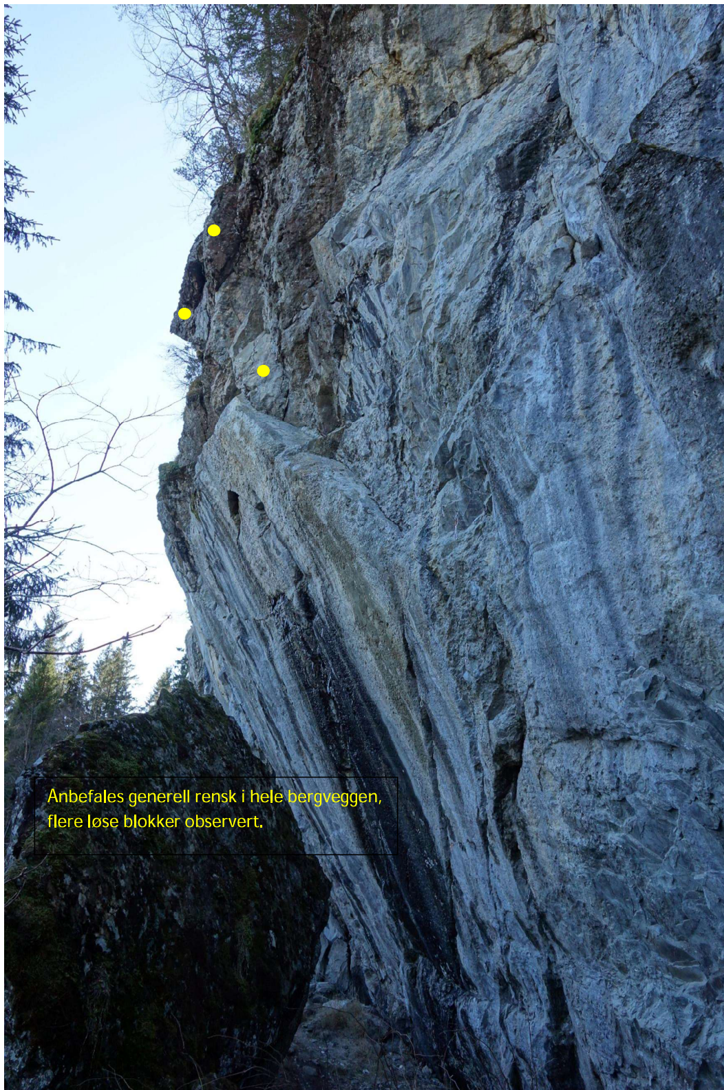
Bilde 14: Lokalitet 11. Flere avløste blokker observert over rutene Best når det heller og Nih Mihn Wang. Årlig observasjon anbefales inntil tiltak med rensk og 3 stk bolter utføres.
