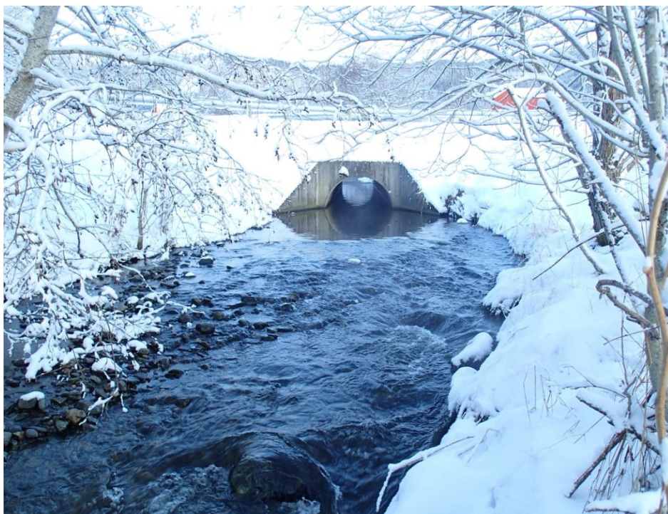
Figur 4-4 Holelva med kulvert under Holvegen, Foto: Sweco
