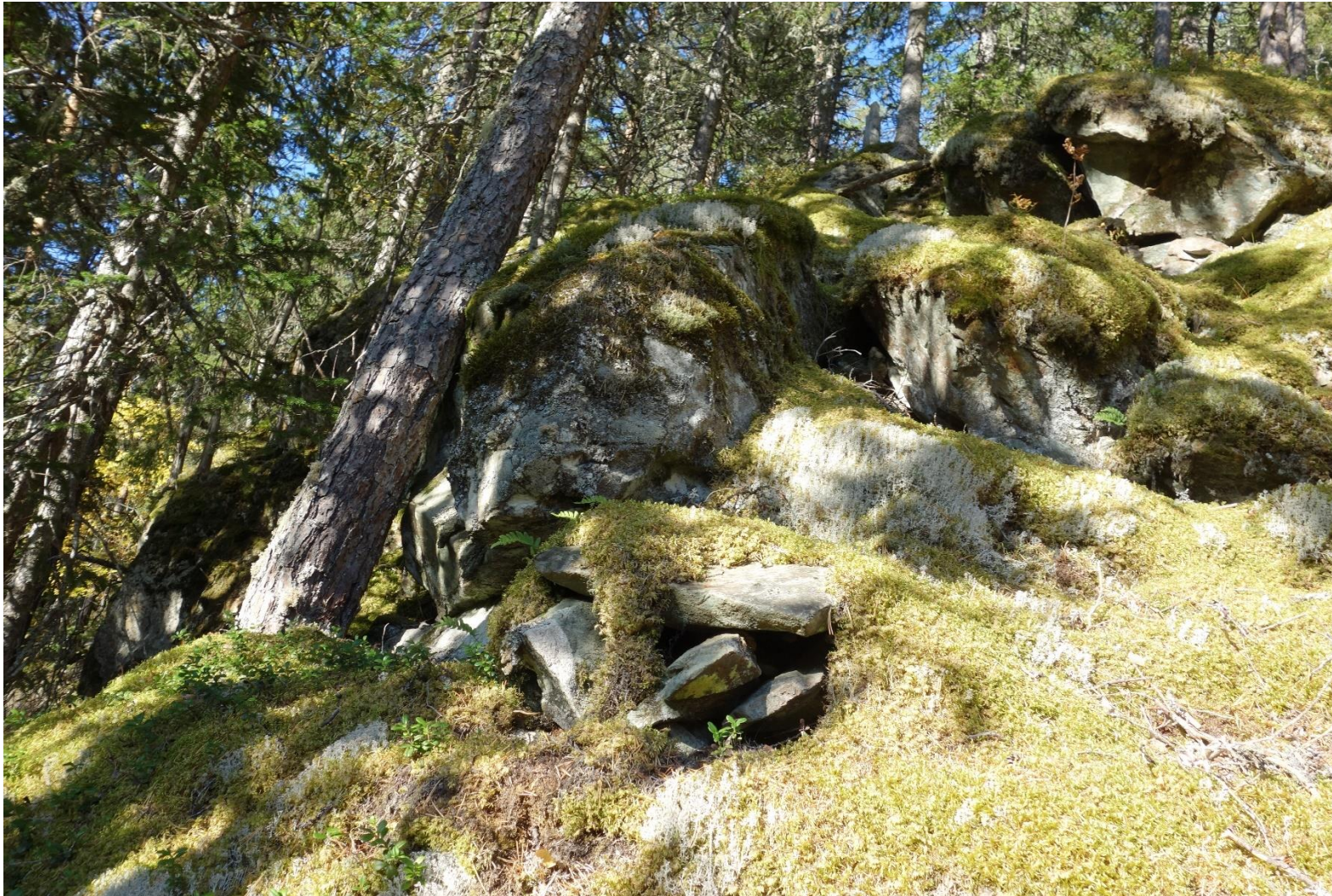
Bilde 8: Blokk støttes opp av trestamme i sideterrenget over møteplass ved ca. profil -1460. Bilde er tatt i bergknaus på oversiden av driftsveg.
