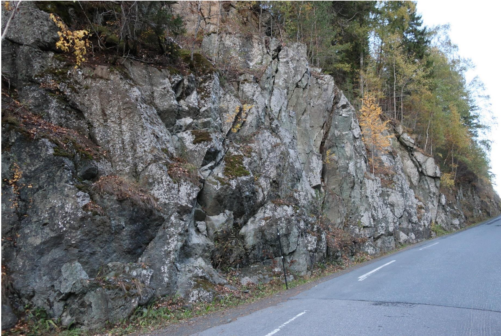
Bilde 2: Eksisterende bergskjæring ved ca. profil -290. Bilde tatt mot nordøst.
