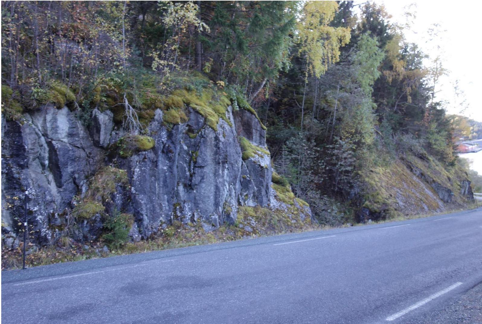
Bilde 1: Eksisterende bergskjæring ved ca. profil – 130. Bilde tatt mot sørvest.
