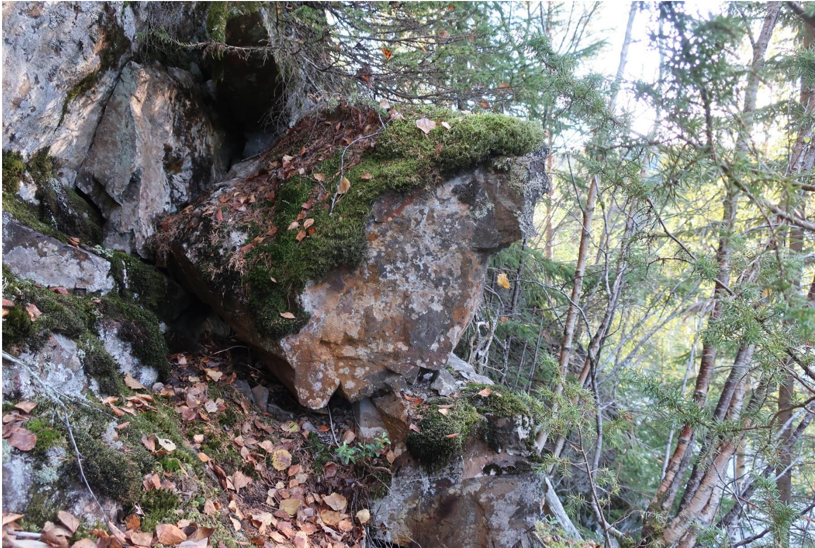
Bilde 11: Blokk i sideterreng over møteplass ved ca. profil -2220.
