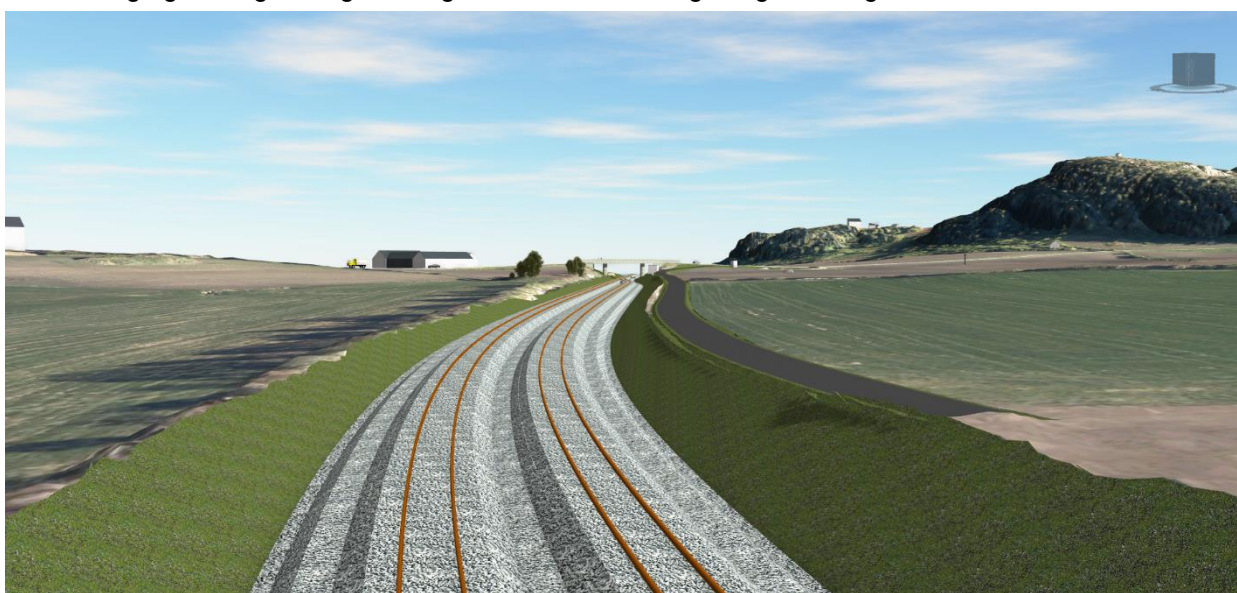
Figur 30 Kryssingssporet sett sørrfra, som viser forsenkingen ned i landskapet med skråning opp mot jordene på begge sider av sporet.
