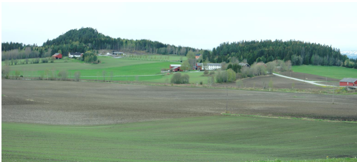
Figur 7 Planområdet sett fra Alstadvegen i øst ved Heggjasberget på veg ned mot planområdet. Åsene mot Trondheimsfjorden er godt synlige, og Alstad gård ligger midt i bildet. Selve jernbanesporet krysser landskapet midt i bildet (se stripe med kantvegetasjon), og går bl.a. under Seterbru (helt til høyre i bildet).
