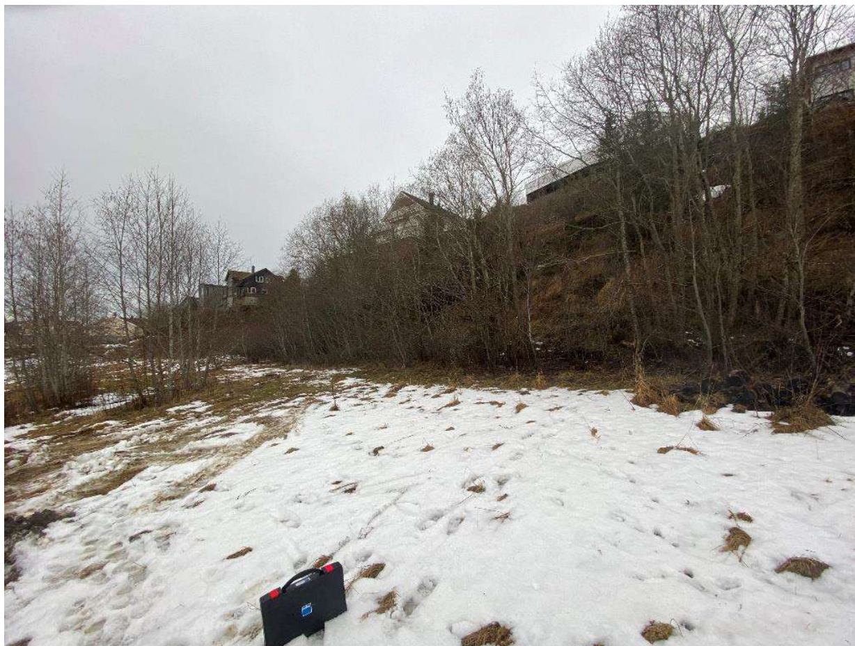
> Foto 4: Bergskråning på sørsiden av boligene langs Dullumsvegen
