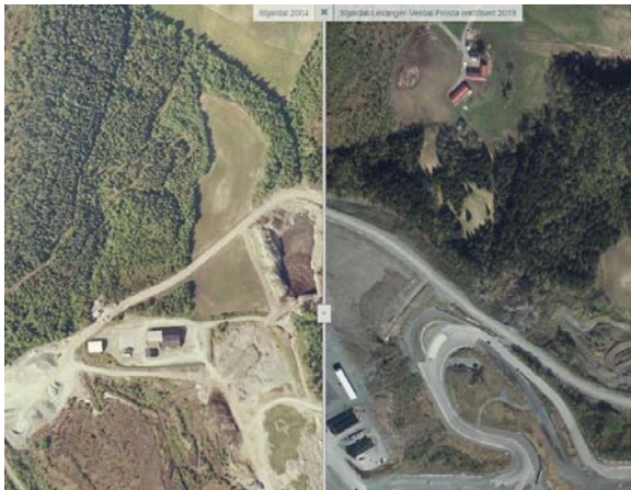
Bildet viser situasjonen i 2004 til venstre og 2019 til høyre. Vegen ligger lenger inn nå enn da den opprinnelig ble bygget.
